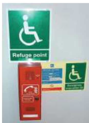
Señalización de zona de refugio.
