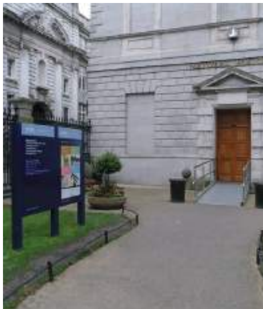
Acceso mediante rampa.
