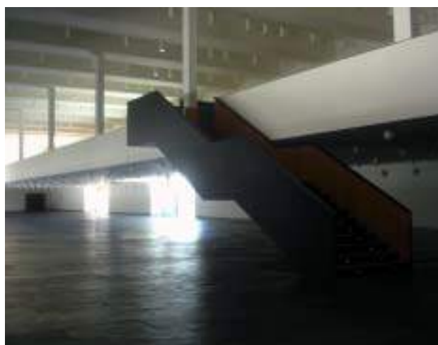
Ejemplo de mala práctica en accesibilidad, una persona con discapacidad visual podría golpearse al caminar bajo la escalera por la falta de un elemento de protección
