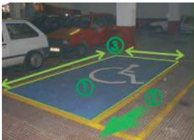
Señalización horizontal de plaza de aparcamiento reservada
