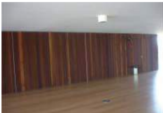
Ejemplo de mala práctica de accesibilidad, las puertas tienen el mismo acabado (color y textura) que la pared, por lo que son difíciles de identificar para cualquier persona con o sin discapacidad visual
