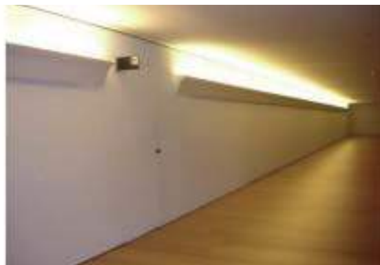
Ejemplo de mala práctica de accesibilidad, las puertas tienen el mismo acabado (color y textura) que la pared, por lo que son difíciles de identificar para cualquier persona con o sin discapacidad visual
