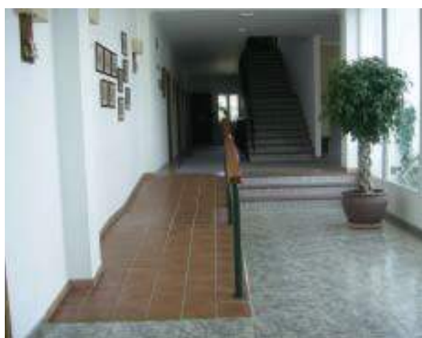
Ejemplo de rampa de suave pendiente construida para salvar 3 escalones. Debe complementarse con un bordillo lateral y dobles pasamanos a ambos lados, prolongados al principio y final de la rampa
