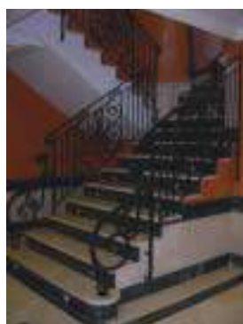
La escalera no cuenta con un zócalo de protección lateral a ambos lados, el pasamanos debe prolongarse hasta el final de la escalera y no rematarse con un elemento decorativo. La estética y la accesibilidad van de la mano, esta barandilla decorativa puede complementarse con un doble pasamanos de madera
