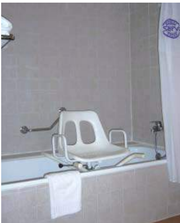
Bañera con asiento giratorio y respaldo y bañera con asiento tipo tabla. Ambos asientos son de quita y pon
