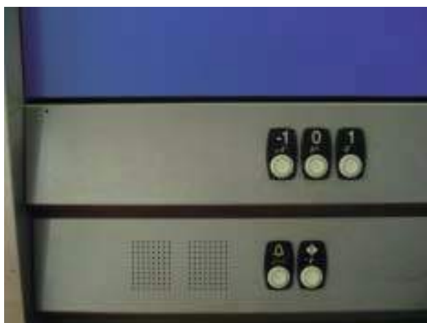
Ejemplo de botonera de cabina de ascensor, números en color contrastado, braille y altorrelieve
