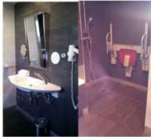
Figura 15: Baño privado de hotel con lavabo sin pedestal y ducha con asiento
