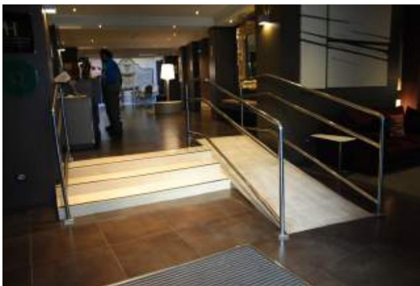
Figura 11: Rampa con doble pasamanos
