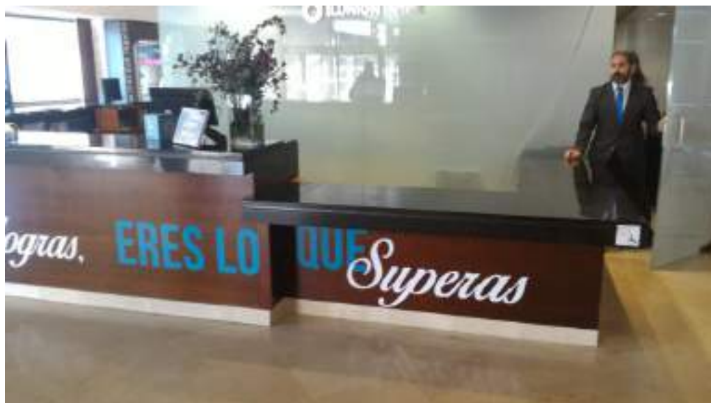
Figura 13: Punto de información con mostrador rebajado
