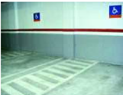
Buena práctica de plazas de aparcamiento reservado para personas de movilidad reducida
