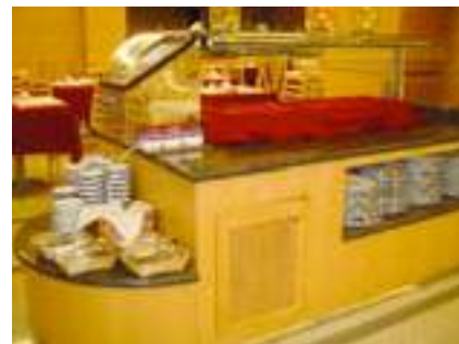
Barra de autoservicio con una altura adecuada para una persona en silla de ruedas y espacio de apoyo para la bandeja. Los platos están bien situados a una altura más baja. La persona en silla de ruedas puede aproximarse lateralmente, pero no frontalmente
