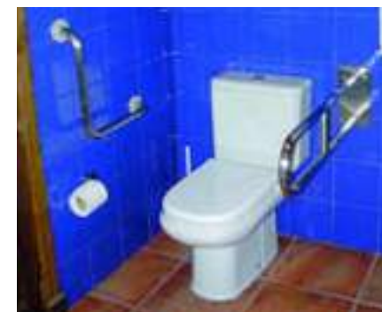
Ejemplo de inodoro con espacio lateral de transferencia en un lado. Barra fija en el lado de la pared y abatible en el lado de la transferencia
