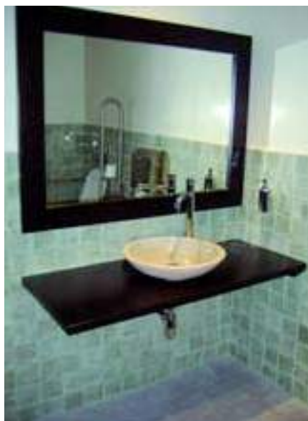
Ejemplo de lavabo y encimera que permiten la aproximación frontal de una persona en silla de ruedas. La grifería situada en la parte inferior del lavabo debería ser un tubo flexible, con aislamiento térmico. El grifo debería tener un mando más grande para facilitar su apertura y cierre a personas con dificultad de manipulación.
