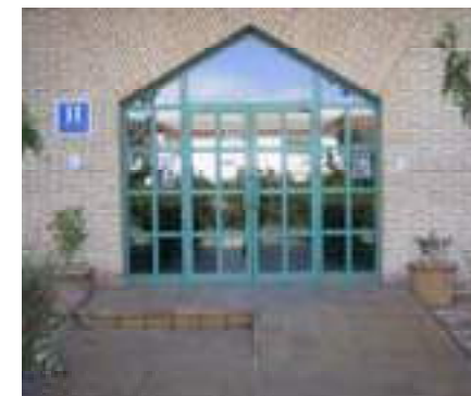
Ejemplo de escalón de acceso a Hotel salvado mediante rampa. Sería conveniente instalar en la rampa un doble pasamanos a ambos lados
