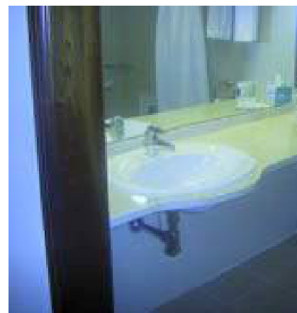
Ejemplo de lavabo y encimera que permiten la aproximación frontal de una persona en silla de ruedas. La grifería situada en la parte inferior del lavabo debería ser un tubo flexible, con aislamiento térmico
