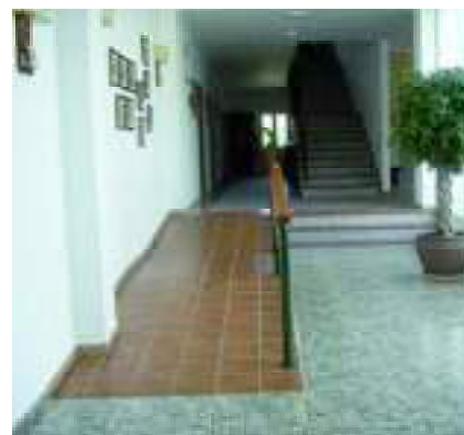
Ejemplo de rampa de suave pendiente construida para salvar 3 escalones. Debe complementarse con un bordillo lateral y dobles pasamanos a ambos lados, prolongados al principio y final de la rampa
